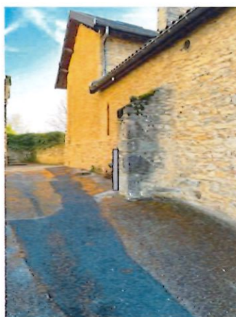
Vue depuis l'angle de la façade de l'église
